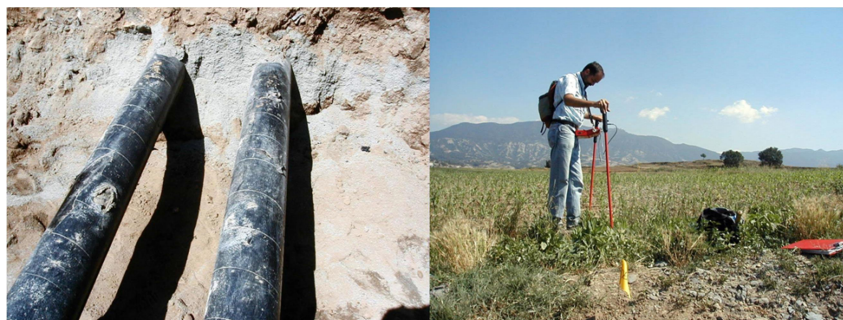
Inspección mediante la DCVG del personal de Procainsa SA
